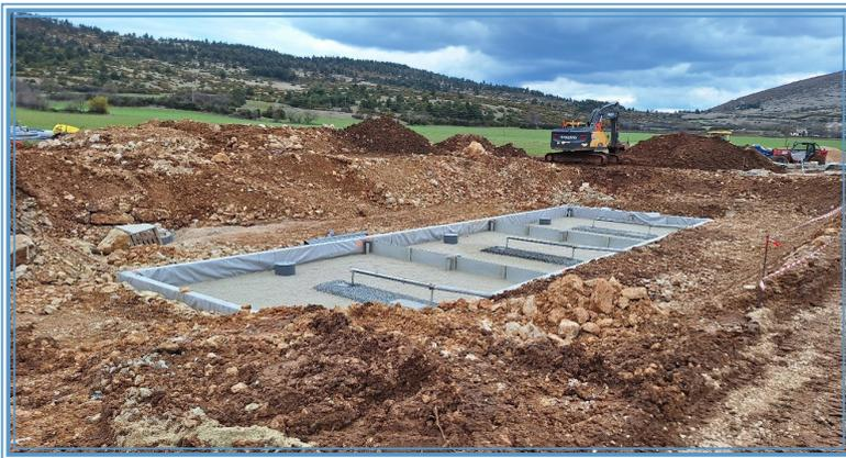
Les travaux ont consisté : à la mise en place d'un collecteur gravitaire pour les effluents de Mas Saint Chély, le raccordement du collecteur de Caussignac et la création d'un nouvel ouvrage d'épuration de type filtre planté de roseaux.
