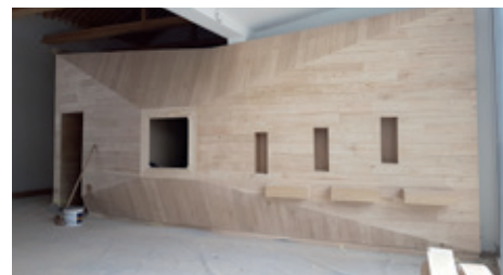
Développement : Maison du tourisme et du Parc national des Cévennes
