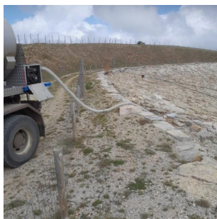
Portage d'eau dans la retenue de Berre
